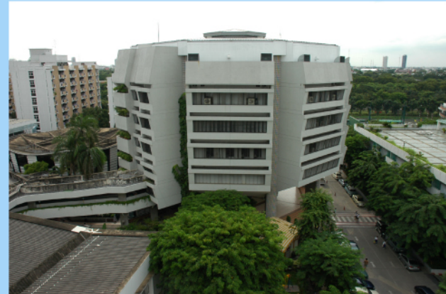
อาคารเรียนรวม
