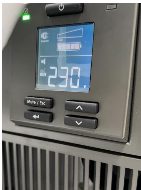
ภาพ แสดงสถานะการเปิดของเครื่องสำรองไฟ
