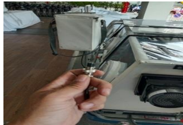
7.ตั้งเสาแบตเตอรี่ต่อมอนิเตอร์
