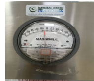
หน้าปิดก่อนปรับปรุง
