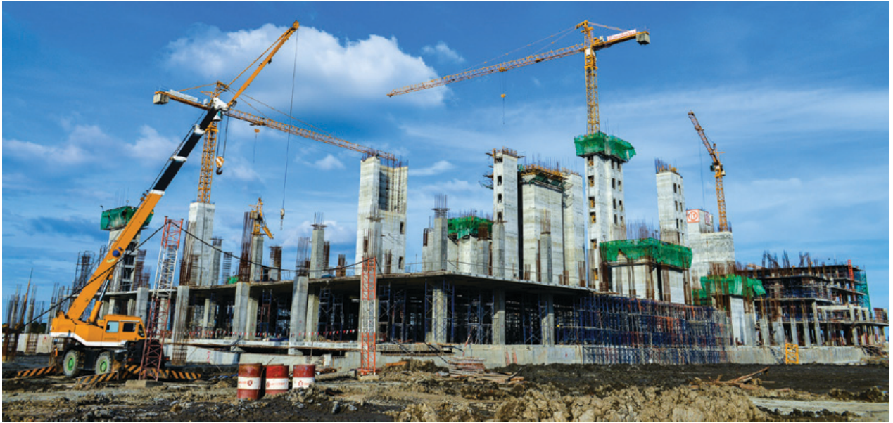
สถาบันการแพทย์จักรีนฤพดินทร์อยู่ระหว่างการก่อสร้าง คาดว่าจะเปิดดำเนินการได้ในปี 2560
